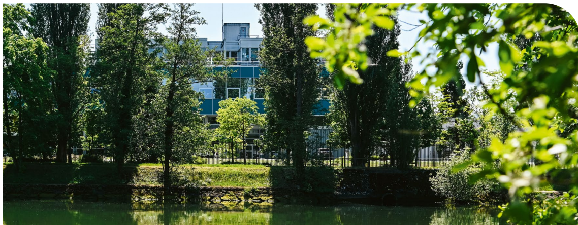
Usine de Méry-sur-Oise (Val d'Oise).
