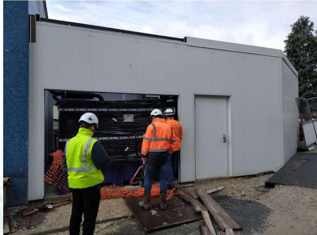
Rénovation de la station de relèvement de Pierrefitte – visuel de la station de pompage provisoire en travaux
