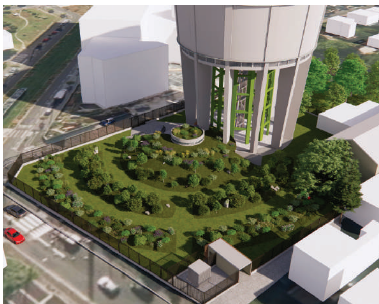
> Visuel du projet de rénovation des réservoirs de Montfermeil (Seine-Saint-Denis).
