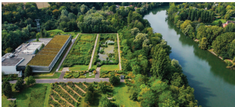
> Vue par drone de l'usine de Méry-sur-Oise (Val-d'Oise) et de la rivière Oise.
