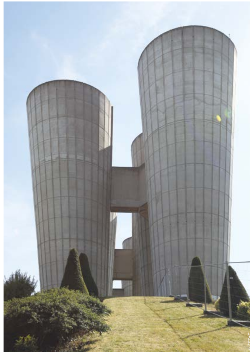
Réservoir de Villejuif
