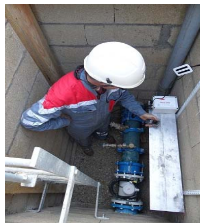
Mise en service d'une sonde Kapta™ 3000 par envoi d'un SMS (Site de L'Hajj-les-Roses)
