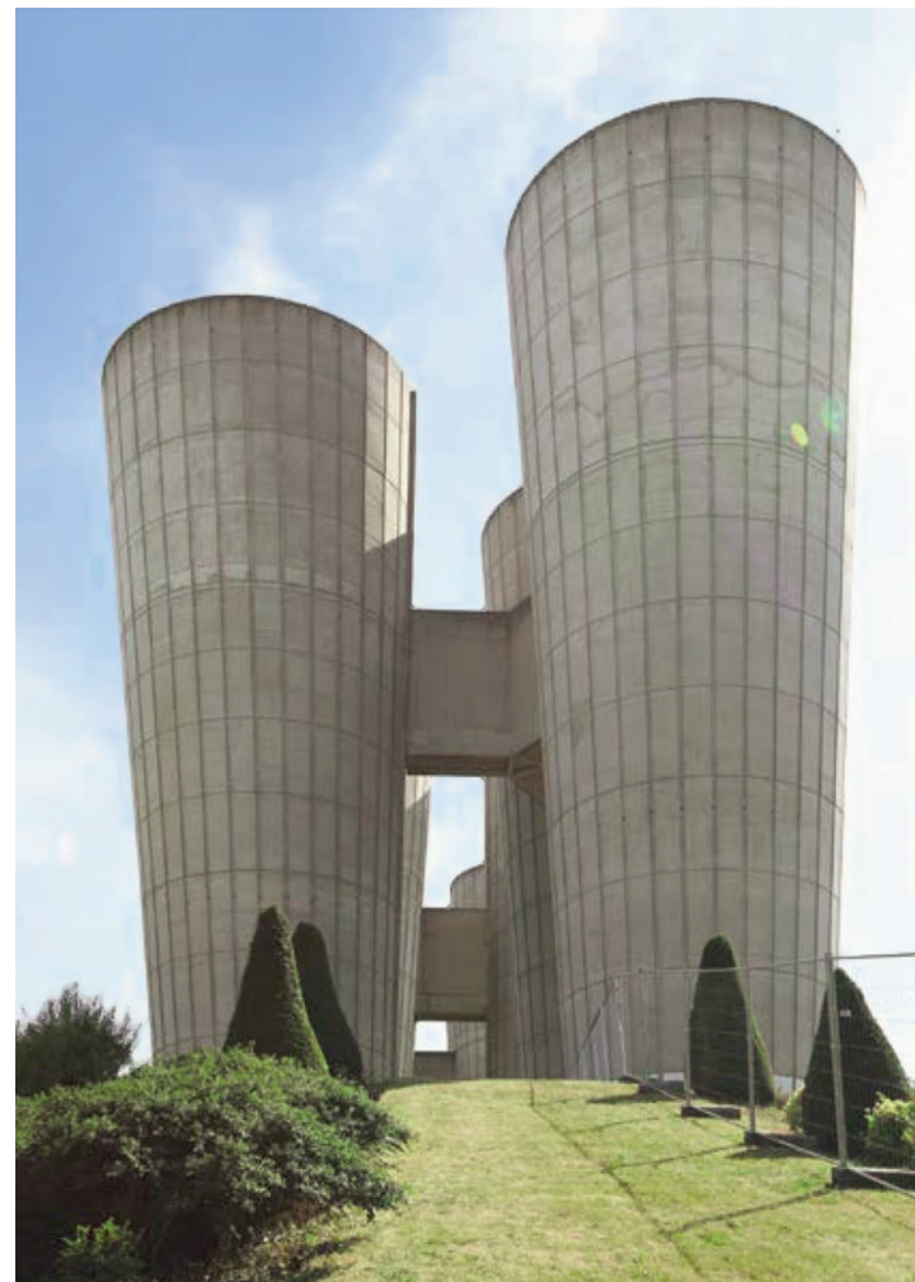
Réservoir de Villejuif
