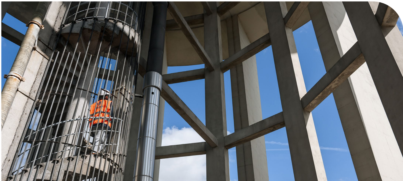
Le château d'eau de Montfermeil (93)
