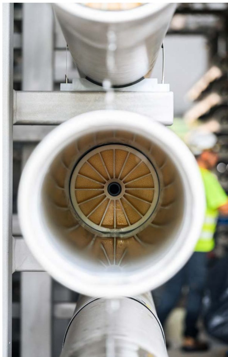
Les membranes en cours de remplacement à l'usine de Méry-sur-Oise.
