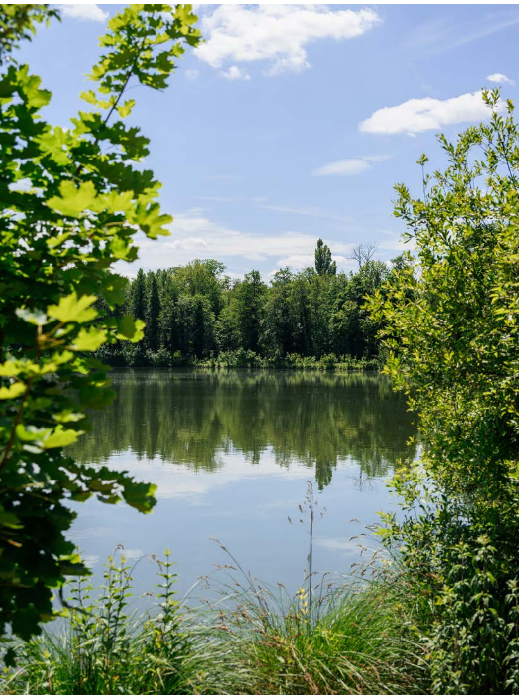
Le bassin de stockage de l'usine de Méry-sur-Oise.
