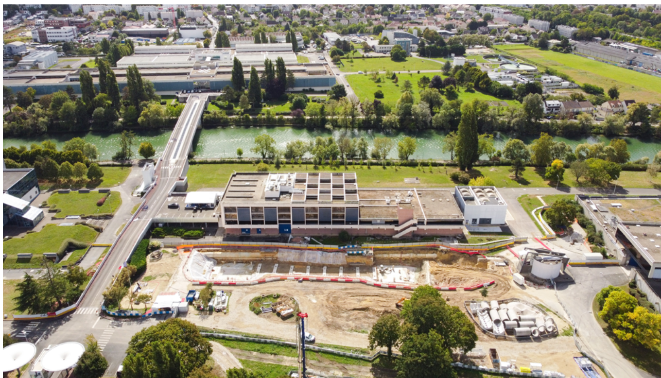
Vue par drone de l'usine avec, au premier plan, les travaux en cours de doublement d'une conduite d'eau potable en DN 2000.
