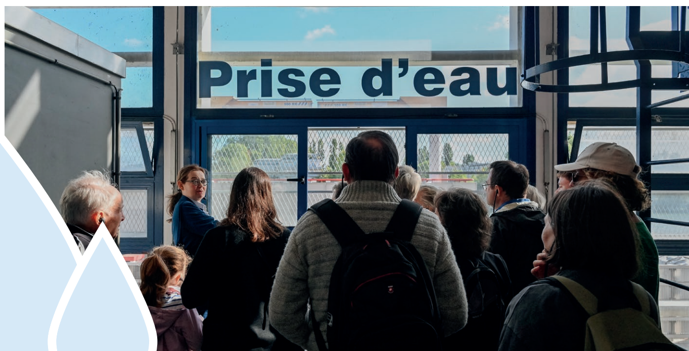
La prise d'eau de l'usine de Choisy, en bord de Seine.
