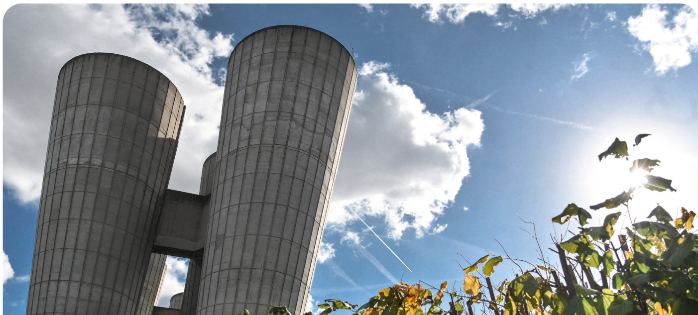
Les réservoirs de Villejuif (Val-de-Marne).
