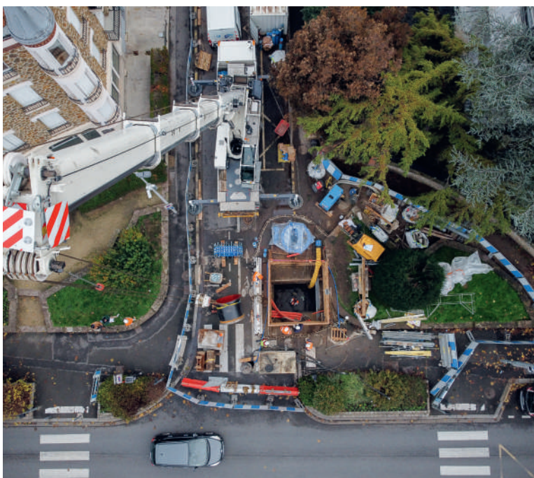
> Vue par drone d'un chantier de remise à niveau d'une chambre à vannes à Villemomble (Seine-Saint-Denis).
