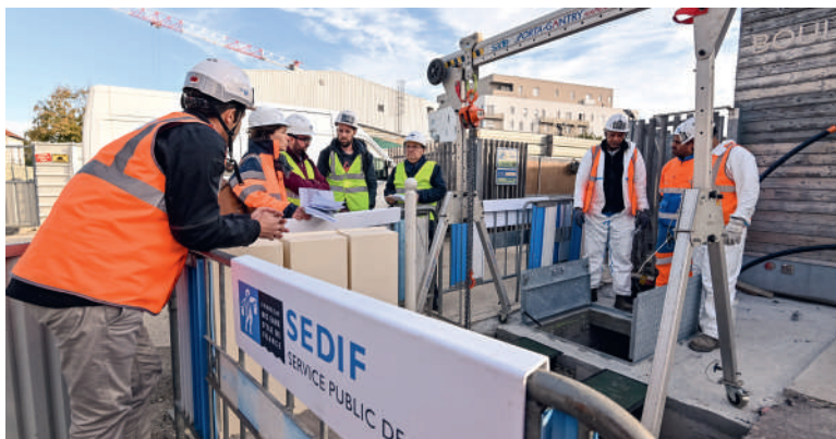
> Les travaux ont notamment consisté à la pose d'une conduite reliant le forage de géothermie aux ouvrages du SEDIF (octobre 2022).
