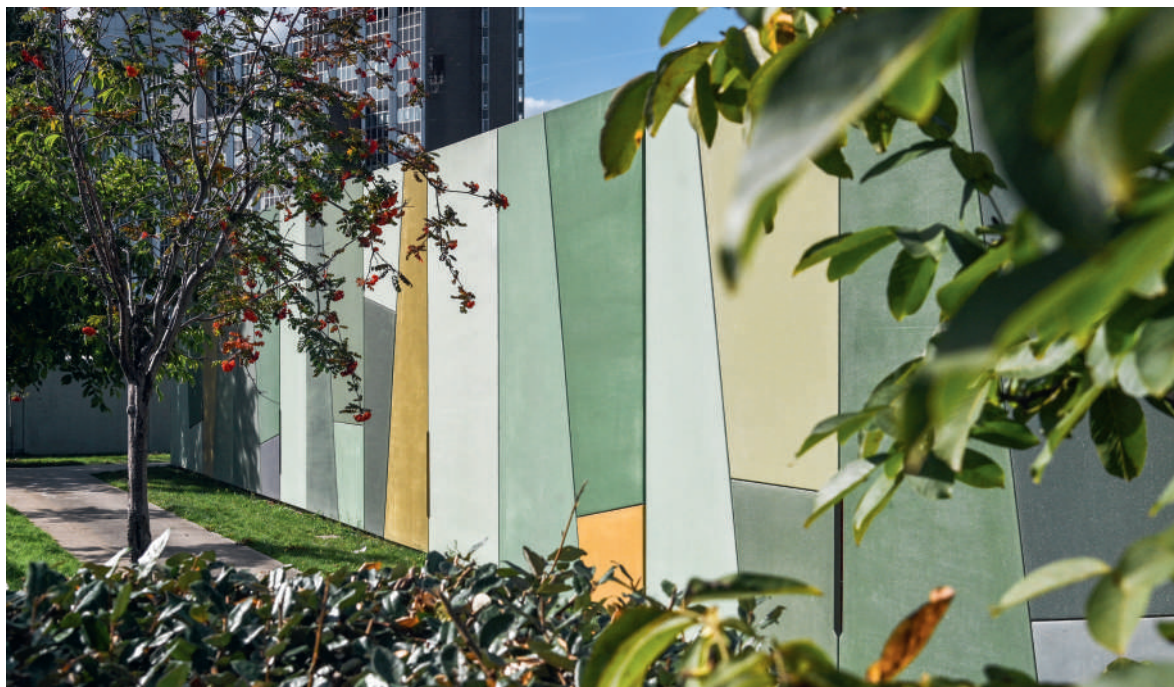
> L'aménagement paysager autour du site de Villejuif est composé notamment d'arbres à feuillage permanent, de plantes couvre-sol sur les talus, d'une pelouse et d'un bassin de récupération des eaux pluviales.
