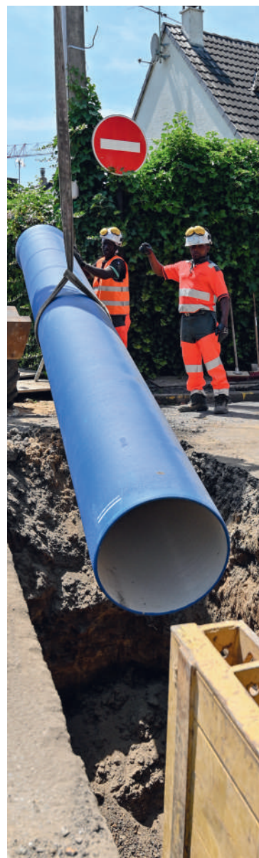
> Renouvellement de canalisations à Livry-Gargan (Seine-Saint-Denis).
