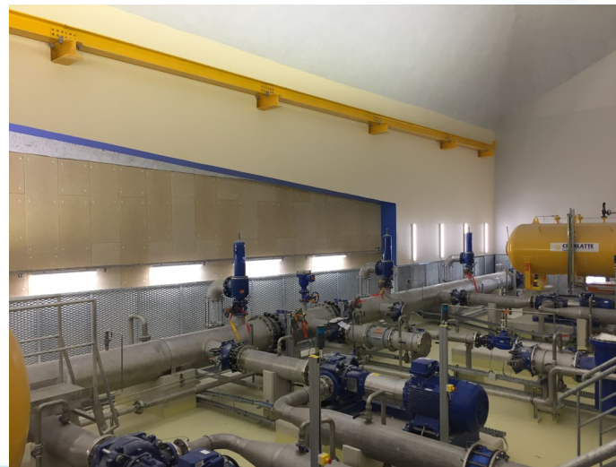
station de PALAISEAU hall des équipements hydrauliques
