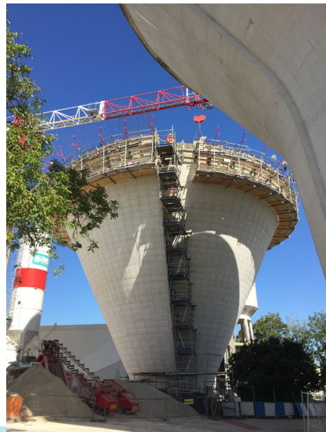
Réservoir R3 Palaiseau
