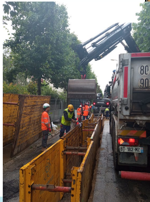
Renouvellement du DN600 St-Maur – Joinville
