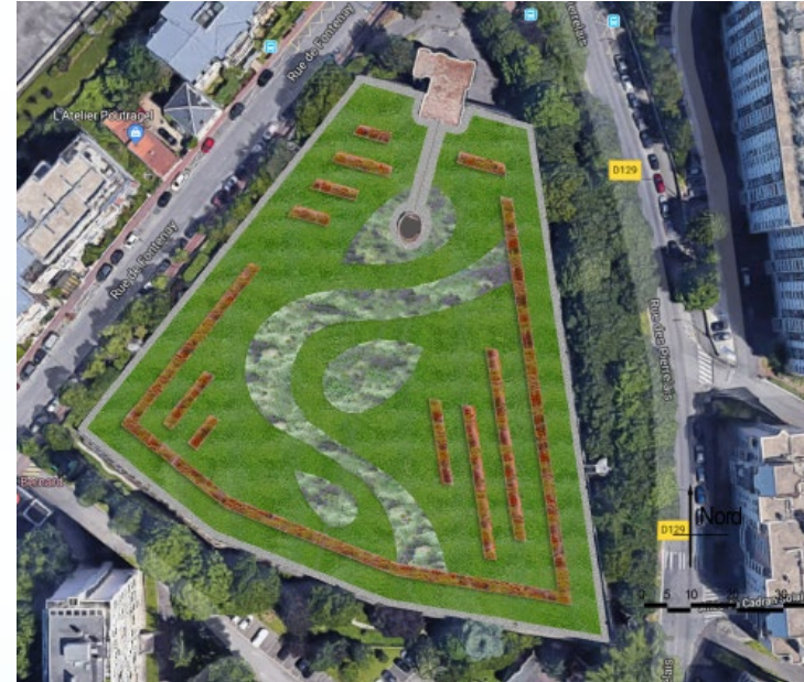
R5 Châtillon Toitures végétalisées des cuves
