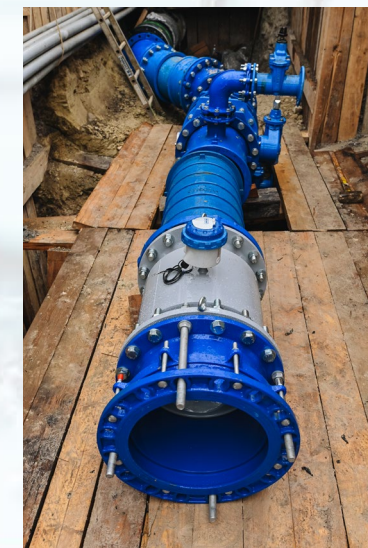
Travaux de sectorisation
