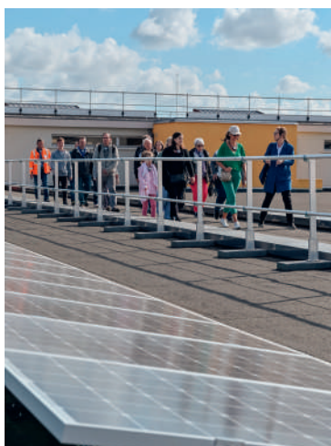
> Passage devant les panneaux photovoltaïques installés en 2019 sur le toit de l'usine de Choisy.
