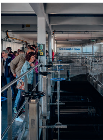
> La décantation : elle marque le début de l'étape de clarification et permet l'élimination des matières en suspension présentes dans l'eau.
