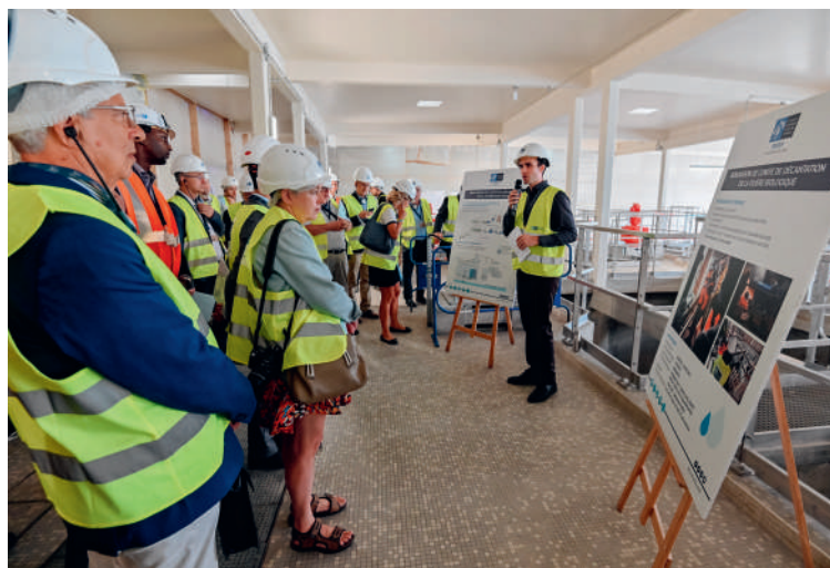
> L'opération de la rénovation des décanteurs se découpe en 3 phases pour maintenir la continuité de service.
